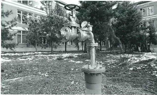
揚水井完了後の様子
