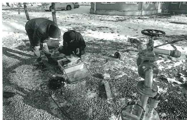
段階注入試験の様子
