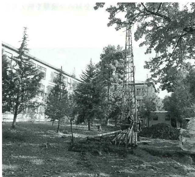
掘削の様子(トラックマウントのロータリーテーブル式掘削機)
