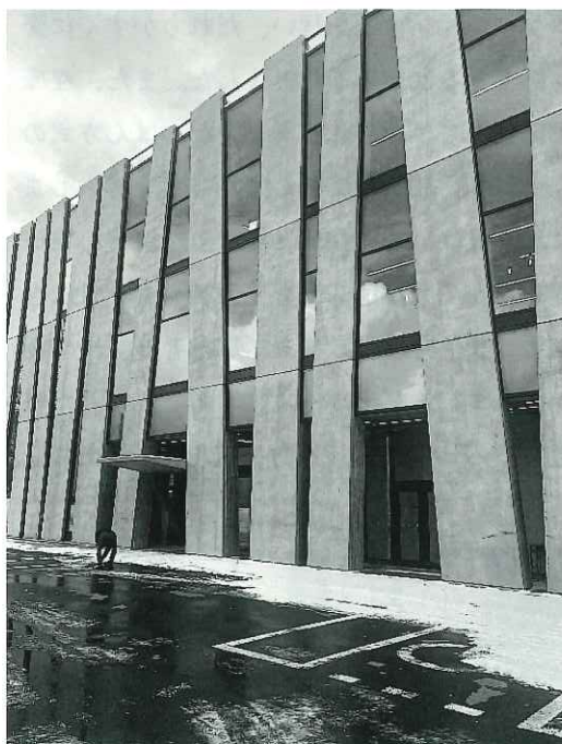
写真7：古平町複合施設外観
