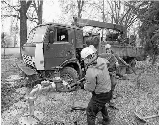
完成した井戸に配管をつなぐ日本地下水開発の社員ら＝昨年12月、タジキスタン（同社提供）
