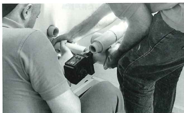
現地業者による配管作業
