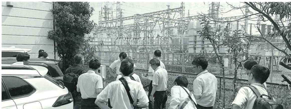
株式会社日さく埼玉工場における地中熱利用施設見学の様子 7月9日(水)
