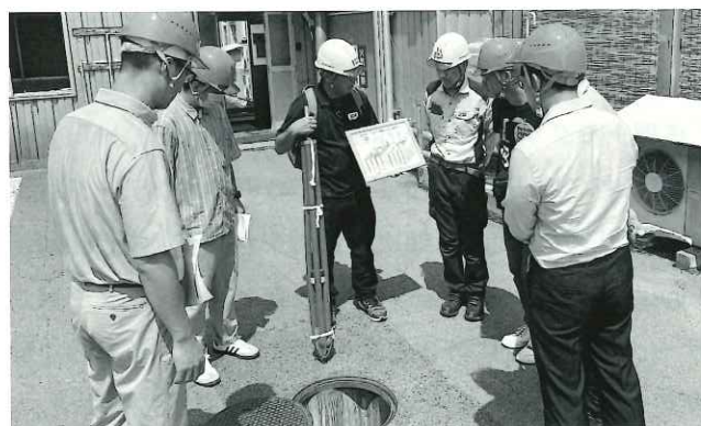
地中熱ヒートポンプシステム視察の様子
