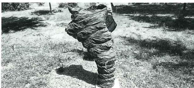
昨年施工した井戸設備
