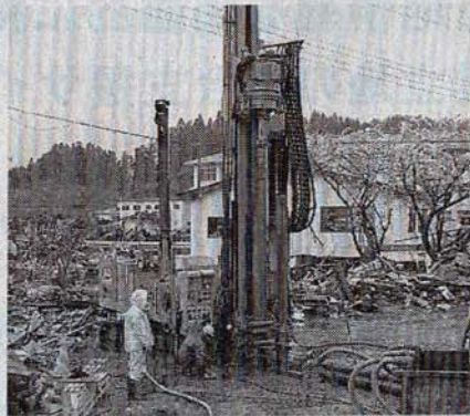
井戸掘削では超高速ボーリング機「ソニックドリル」が威力を発揮した（岩手県陸前高田市）
