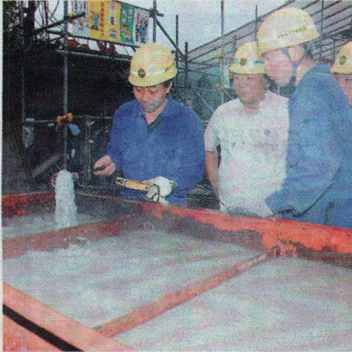
泥水交じりで湯が噴き出した柳川温泉の 新源泉掘削工事現場 =大江町柳川
