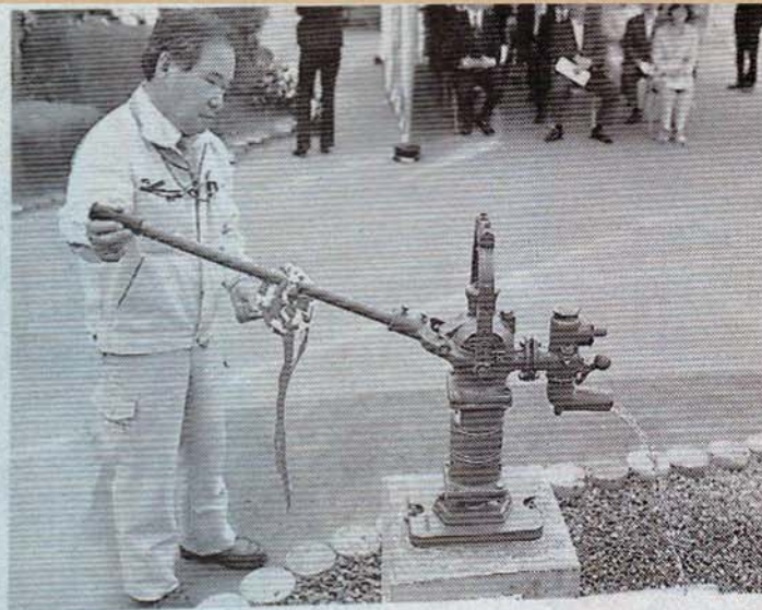
山形市立西小の「ぼうさい井戸」。手押し式だから停電時にも地下水をくむことができる。山形市西田3丁目
