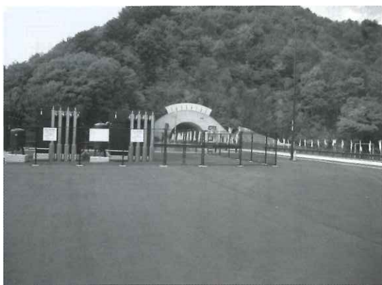
ヒートポンプと大滝トンネル
