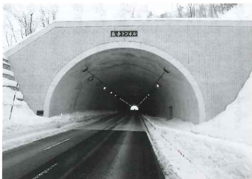
トンネル入口
