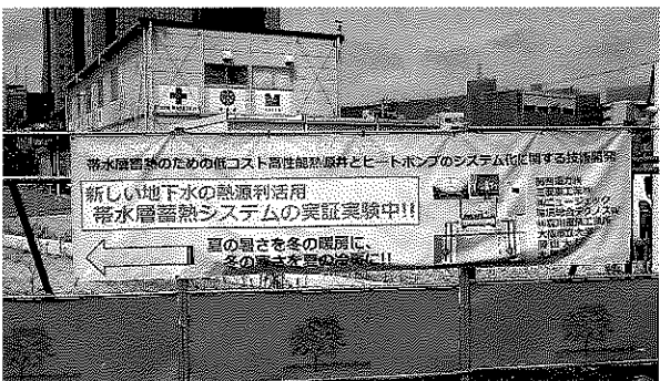
施設見学 うめきた再開発地区帯水層蓄熱システム実証施設
