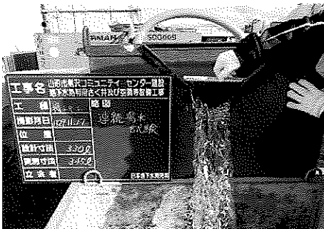
連続揚水試験状況
