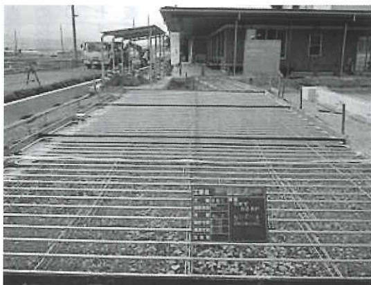
放熱管敷設状況
