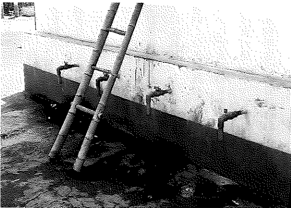
機械室に設置された蛇口
