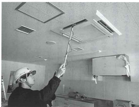
試運転確認状況
