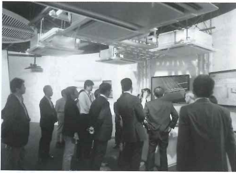
体感型ショールームでの視察状況(熱源は1つであるが、部屋毎に冷房・暖房が独立して同時に行えるシステムが、電気の色別で示してある)
