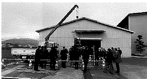
非開削工法 試験施工状況
