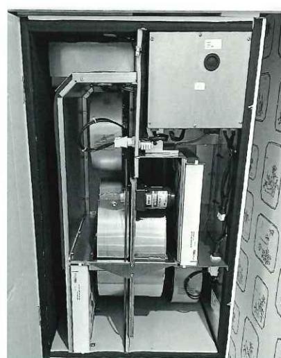
平清水の家に設置された全熱交換換気システム
