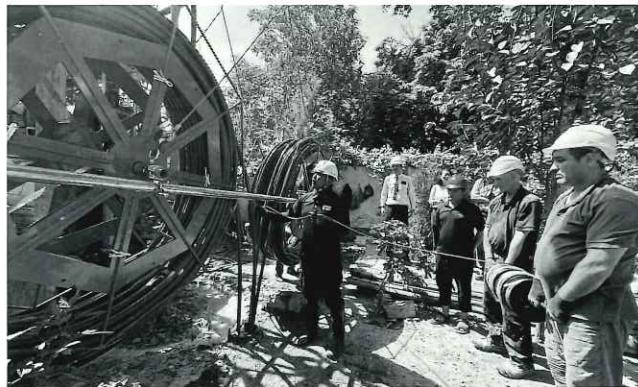
WUチューブ・温度センサーの挿入
