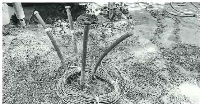
WUチューブ挿入・砂利充填完了（2孔目）
