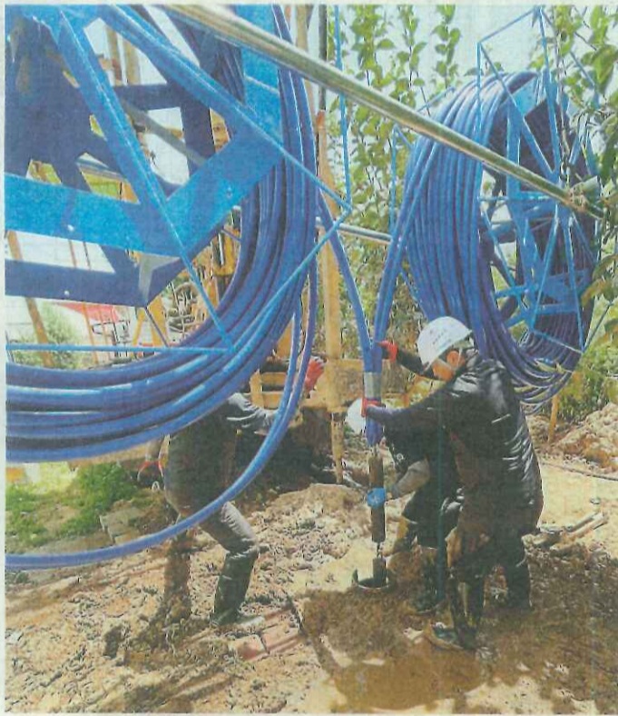
2本一組のU字形チューブを井戸の中に入れる作業 今年7月、タジキスタン（日本地下水開発提供）
